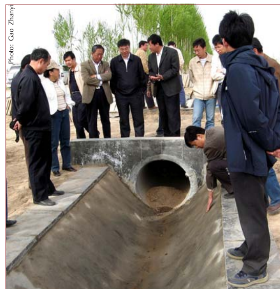
Visite de l'Equipe de recherche au Projet d'irrigation Hetao en Mongolie pour examiner le revêtement géosynthétique argileux (GCL) des canaux
