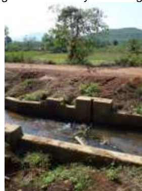
(d) Informal cross regulator and slotted offtake
